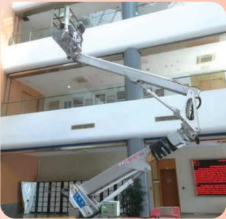
▲对修远楼B区大厅顶部老旧灯具进行拆除改造。
